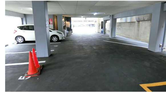
ホテル下駐車場
